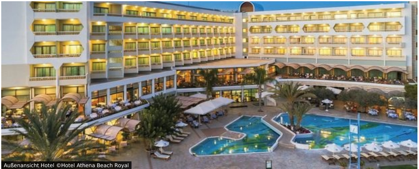
Außenansicht Hotel ©Hotel Athena Beach Royal
